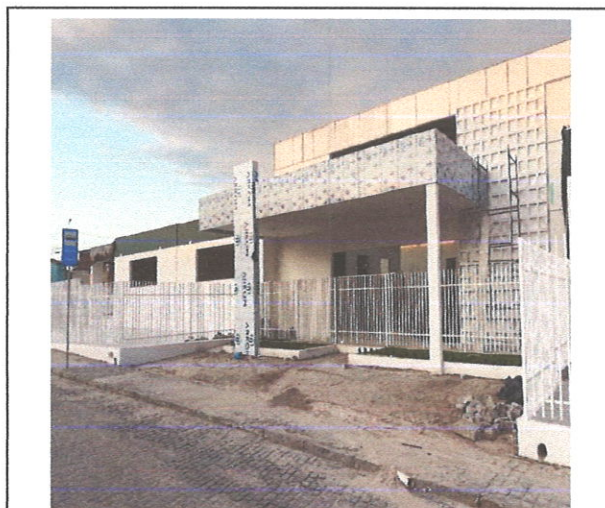
FOTO 170: Instalação do Alumínio Composto (Fachada)
