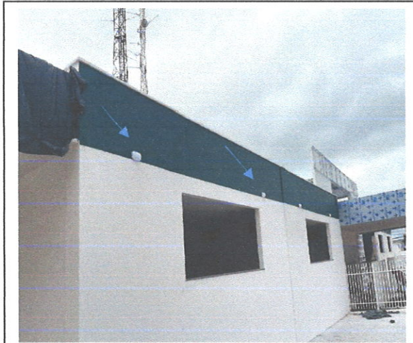
FOTO173: Instalação luminária tipo tartaruga (Fachada)
