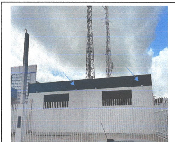
FOTO175: Instalação luminária tipo tartaruga (Fachada)
