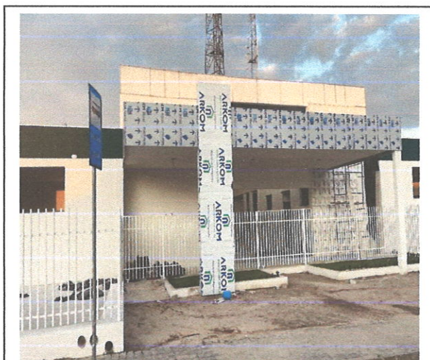
FOTO169: Instalação do Alumínio Composto (Fachada)
