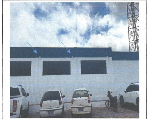
FOTO 174: Instalação luminária tipo tartaruga (Fachada)
